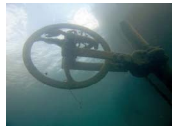
Structure à -3m
